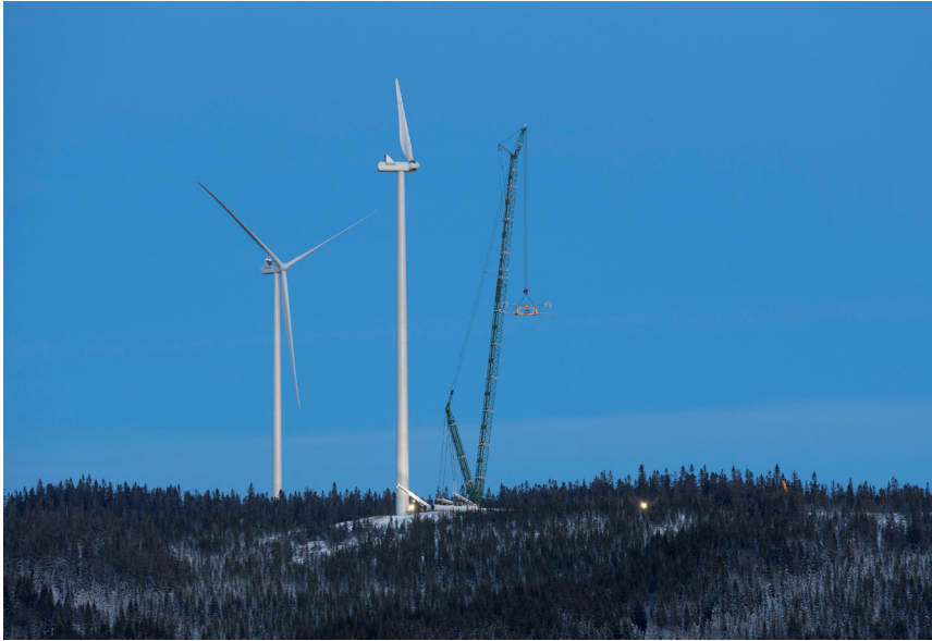
Bygging av Kjølberget kraftverk på Finnskogens høyeste punkt, 2020. Foto: Bård Løken, Anno Norsk skogmuseum.
