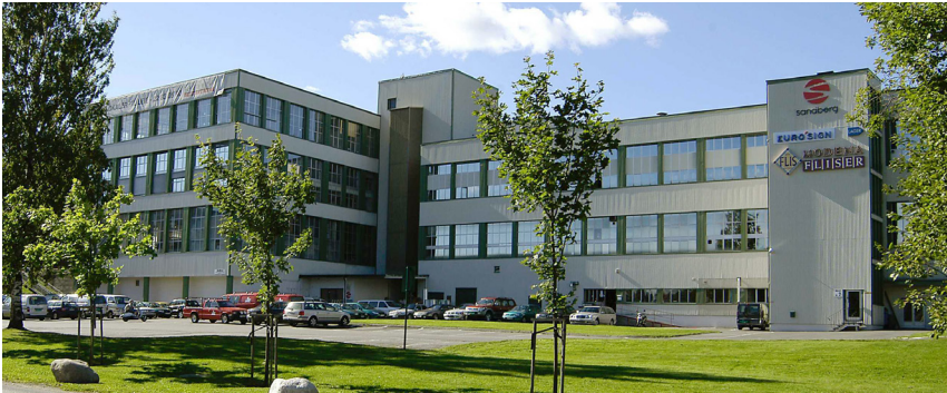
Tefas-fabrikken med adresse Frysjaveien 40. Bygd i 1949, nedlagt i 1957. I åtte år ble bygningen brukt til det den var bygd for – tekstilforedling. I 2022 ble bygningen revet. Foto: Finn Larsen / Norsk Teknisk Museum, 2004.
